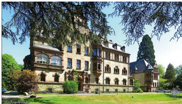
Physikzentrum Bad Honnef.
