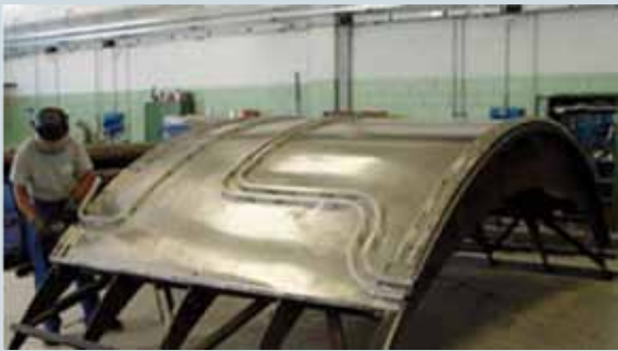
Fase di realizzazione di un settore di schermo criogenico in lega di alluminio, diametro 6 m, altezza 20 m per criostato elio del supermagnete CMS (CERN Ginevra).
