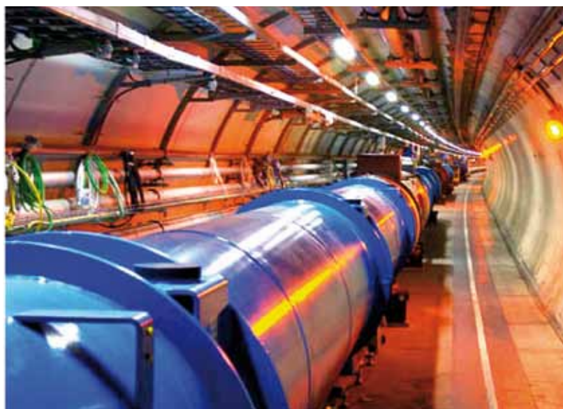
Interno del tunnel di LHC (Credit: CERN/LHC Consortium).
