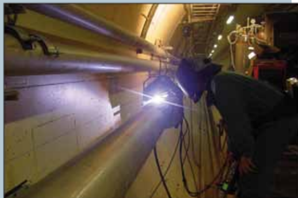
Assemblaggio di una condotta tramite processo semi-automatico di saldatura.
