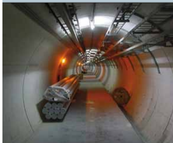
Segmenti di conduttura pronti per l'installazione.
